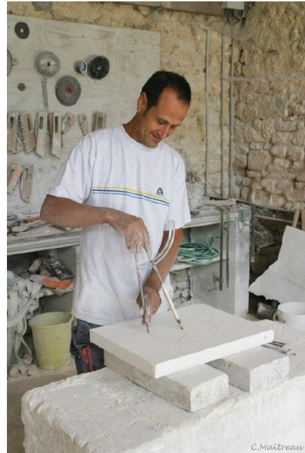
Erick Mettavant, artisan tailleur de pierre sur la commune de Nercillac, trace l'épure d'une rosace qui ornara probablement le manteau d'une cheminée.
