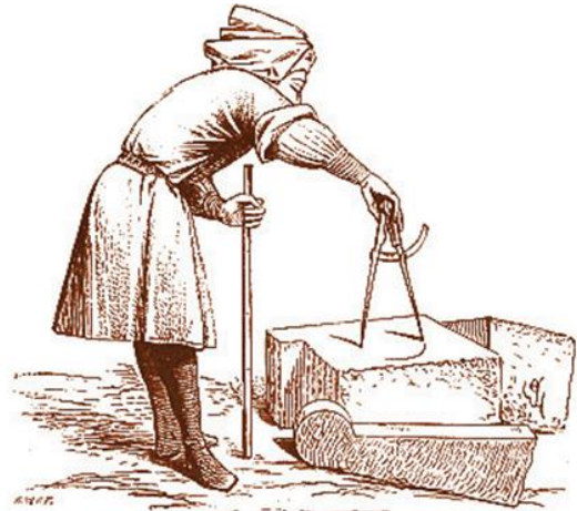
Tailleur de pierre exécutant un tracé sur un bloc de pierre, probablement destiné à orner le fronton d'une église ou d'une cathédrale.
