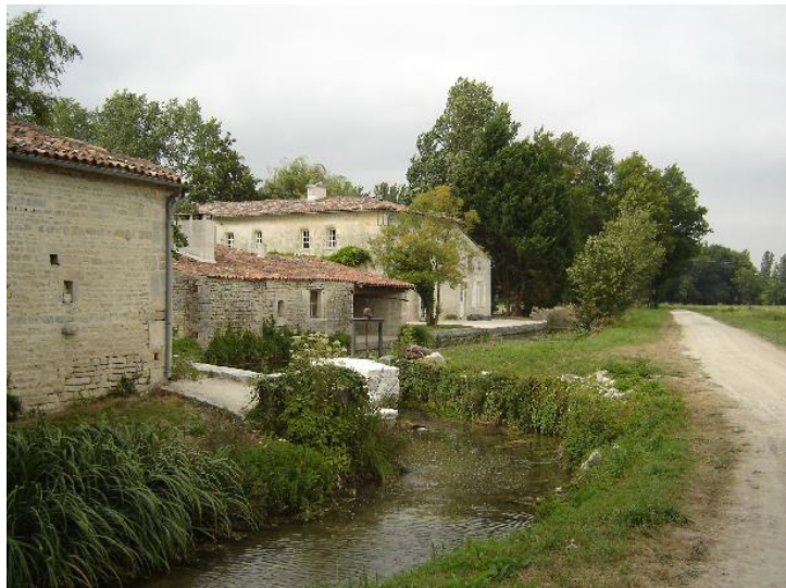
Le logis et le moulin de Bonnet, sur le Dandelot
