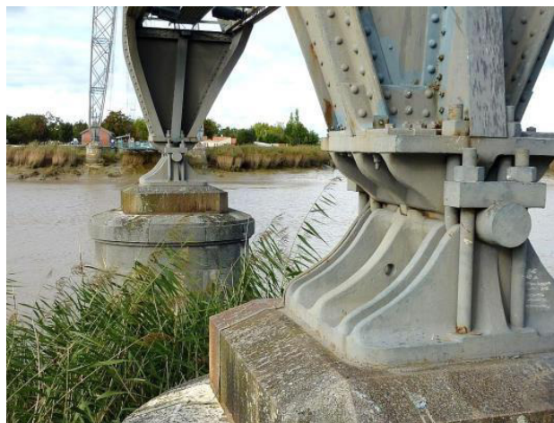
Piles côté Échillais
