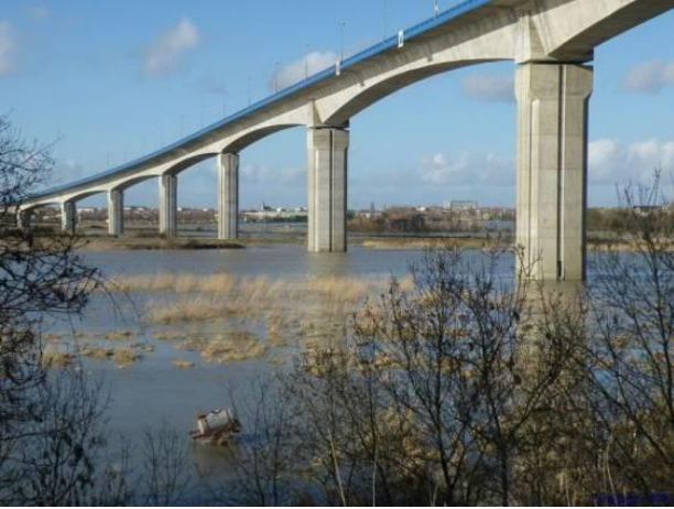
Le viaduc après Xynthia, 28 février 2011
