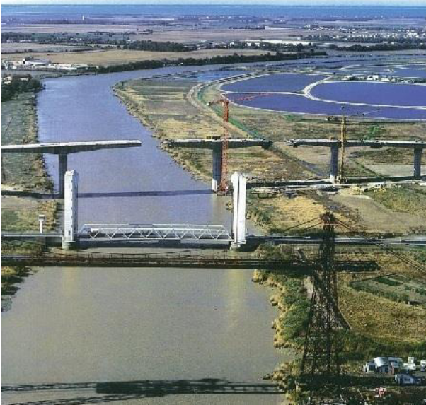
La Charente pendant le chantier du viaduc
