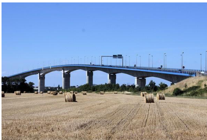
Le viaduc vu depuis les champs
