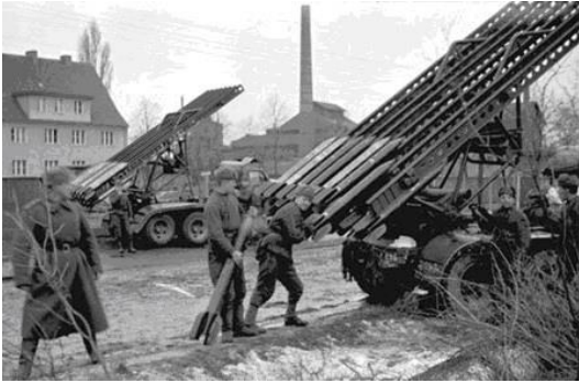
Batteries de lance fusées « Orgues de Staline »
