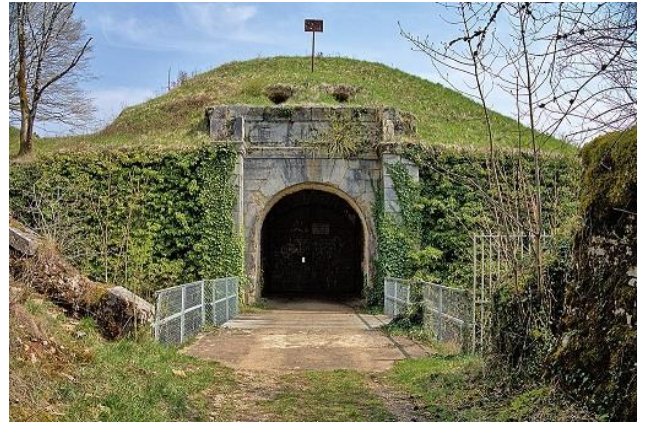
Entrée du fort de Chailluz (photo Wikipedia)
