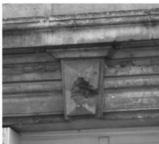
clé de la fenêtre au centre endommagée par un impact de balle
