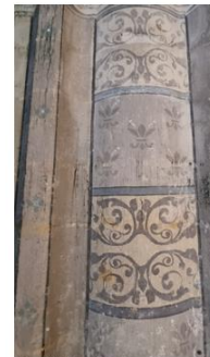
Détail église de Beauvais-sur-Matha
