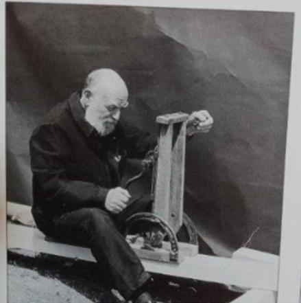
Barn Beam Boring Machine ou Boring machine ou Beam drill (littéralement : machine à faire des trous dans les poutres). C'est un outil de charpentier surtout utilisé en Amérique du Nord (USA et Canada) où exercent des charpentiers habiles et expérimentés, et où les constructions en bois sont très nombreuses (Ma cabane au Canada). L'outil est aussi un peu connu en France sous le nom de perceuse à colonne à manivelle ou encore le très pittoresque : vélo de charpentier.
